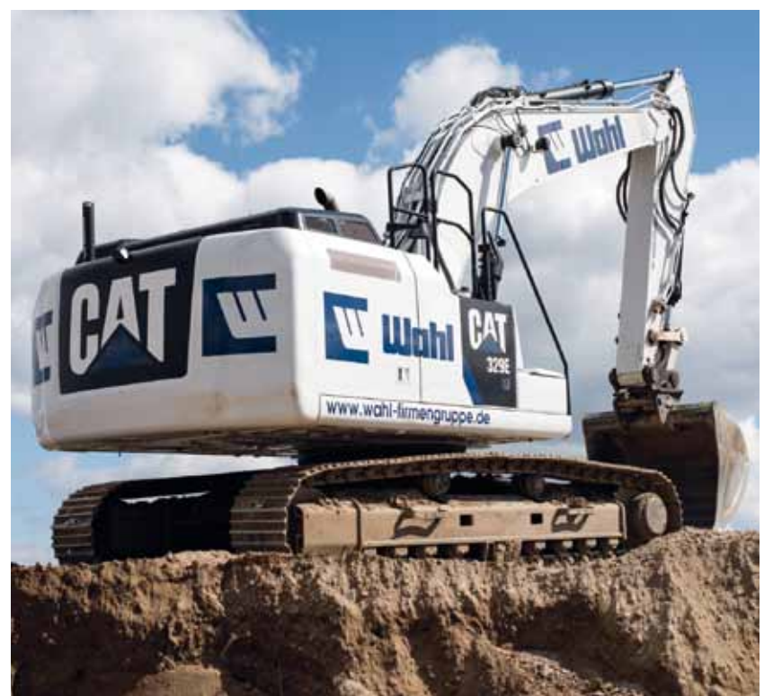
Baumaschinen sind gefordert beim Erdbau.
