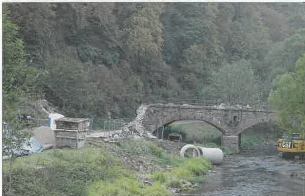
Die Abbrucharbeiten an der Ahrbrücke haben begonnen
