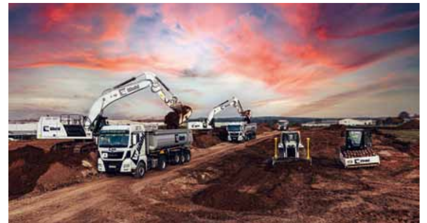
Großaufgebot an Cat Baumaschinen auf der Logistikbaustelle in Polch.
