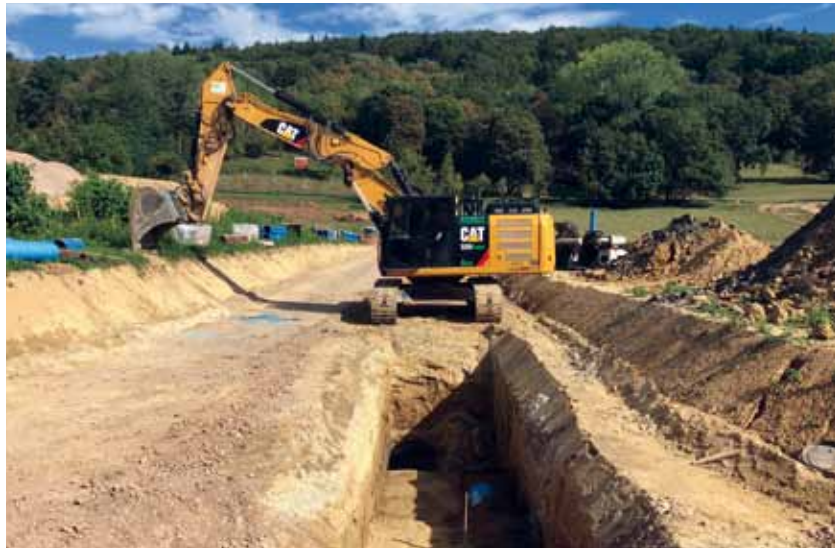
Um 150 Schmutz- und Regenwasserschächte einzubauen, unterstützen das Bauunternehmen Cat Baumaschinen. Fotos: Knäble/Frank Griesbaum
